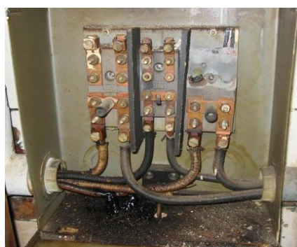
2-расм. Электр қурилмаларининг улаш (контакт) жойлари мустаҳкам бажарилмаганлиги.
