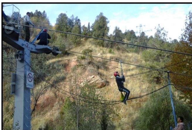
Рис.6. Передвижение спасателя по несущему канату.
