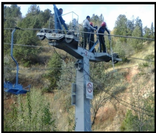
Рис. 5. Установка навесной стремянки на несущий канат.
